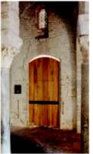
Les portes i finestres, excepte a la zona sud, mantenen la seva estructura original.
