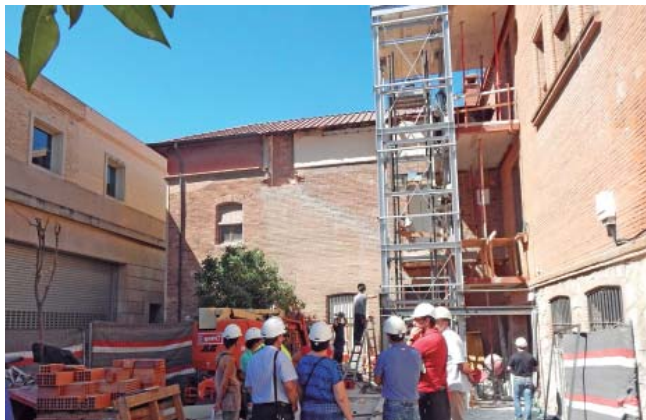
Obres d'instal·lació d'un ascensor a l'escola La Llar
