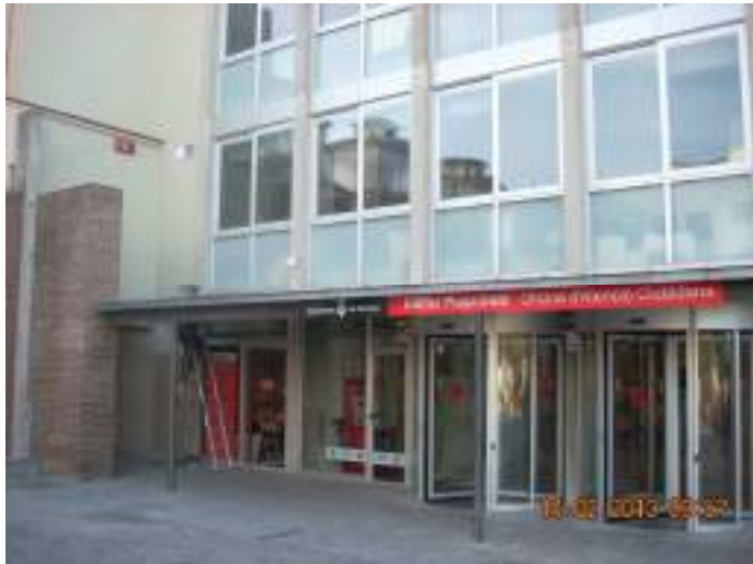
Plaça Dido Serveis Centrals
