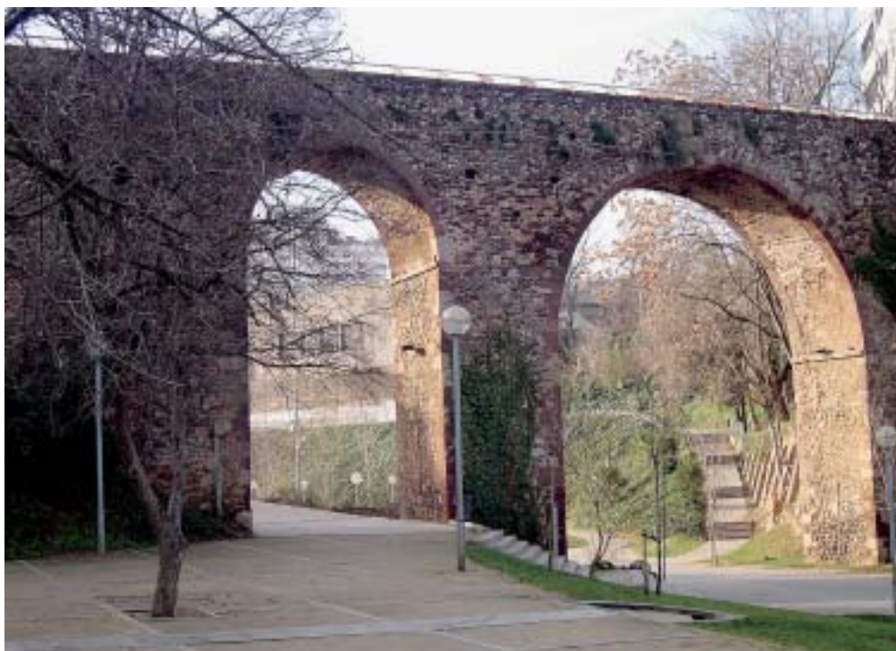
Foto actual del pont de Sant Pere
