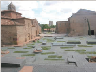
Recinto con la nueva pavimentación. MdT
