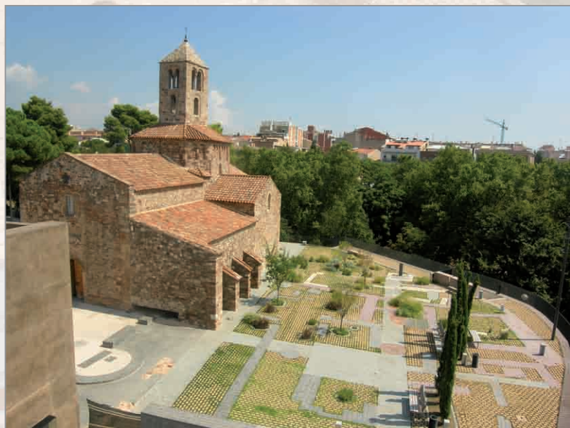
Recinto con la nueva pavimentación. MdT
