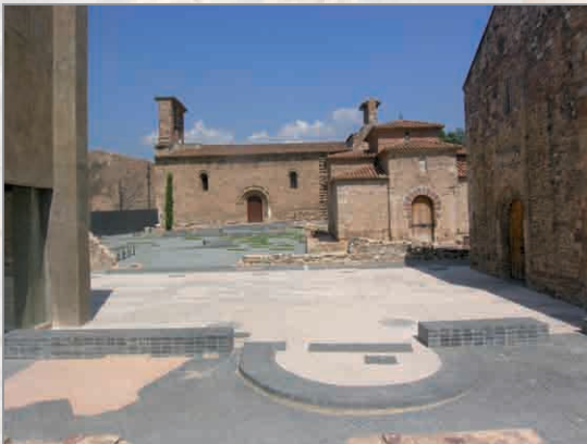
Recinto con la nueva pavimentación. MdT
