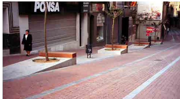
1996. Urbanització del carrer de la Font Vella, Terrassa
