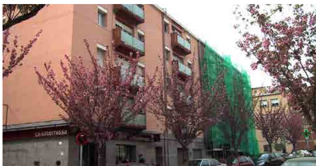
1994 a 2010. Rehabilitació estructural d'edificis d'habitatges amb alumini a Ca n'Anglada, Terrassa. En col·laboració amb l'arquitecte Lluís Satorras
