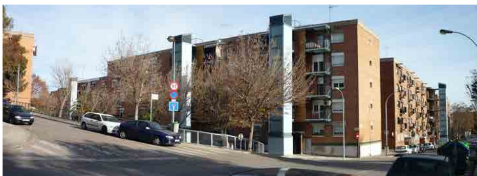
2010. Instal·lació d'ascensors en edificis existents. Can Puiggener, Sabadell. En col·laboració amb l'arquitecte Lluís Satorras
