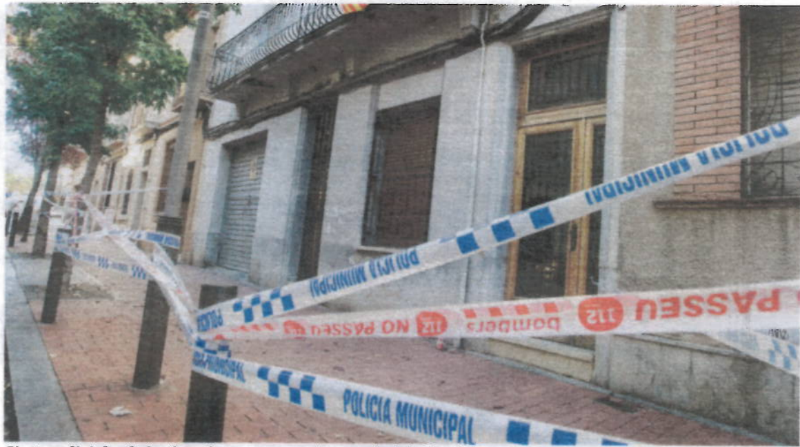
Cinta policial y de los bomberos, ayer en las proximidades del inmueble afectado. NEBRIDI ARÓZTEGUI
