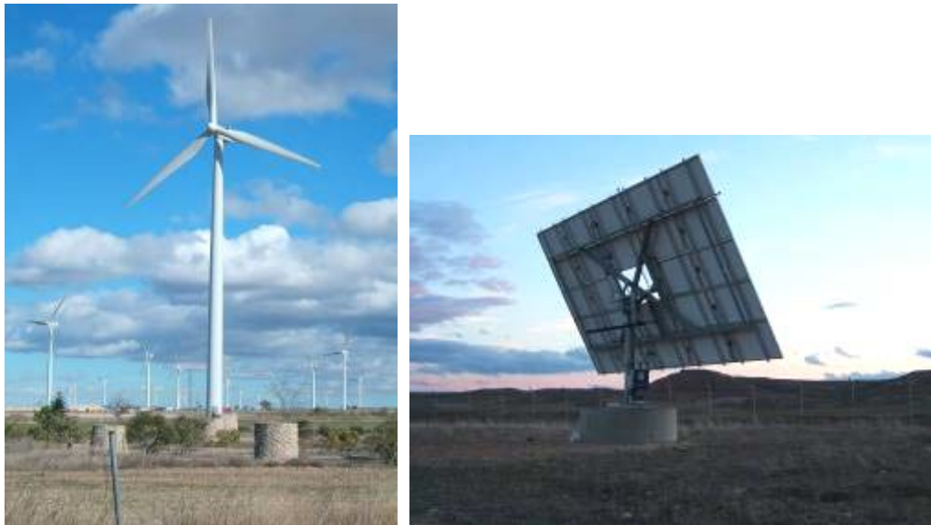
Figura 6. Imatge de la planta de generadors eòlics de La Muela (Saragossa), i seguidor solar de Monteagudo.
