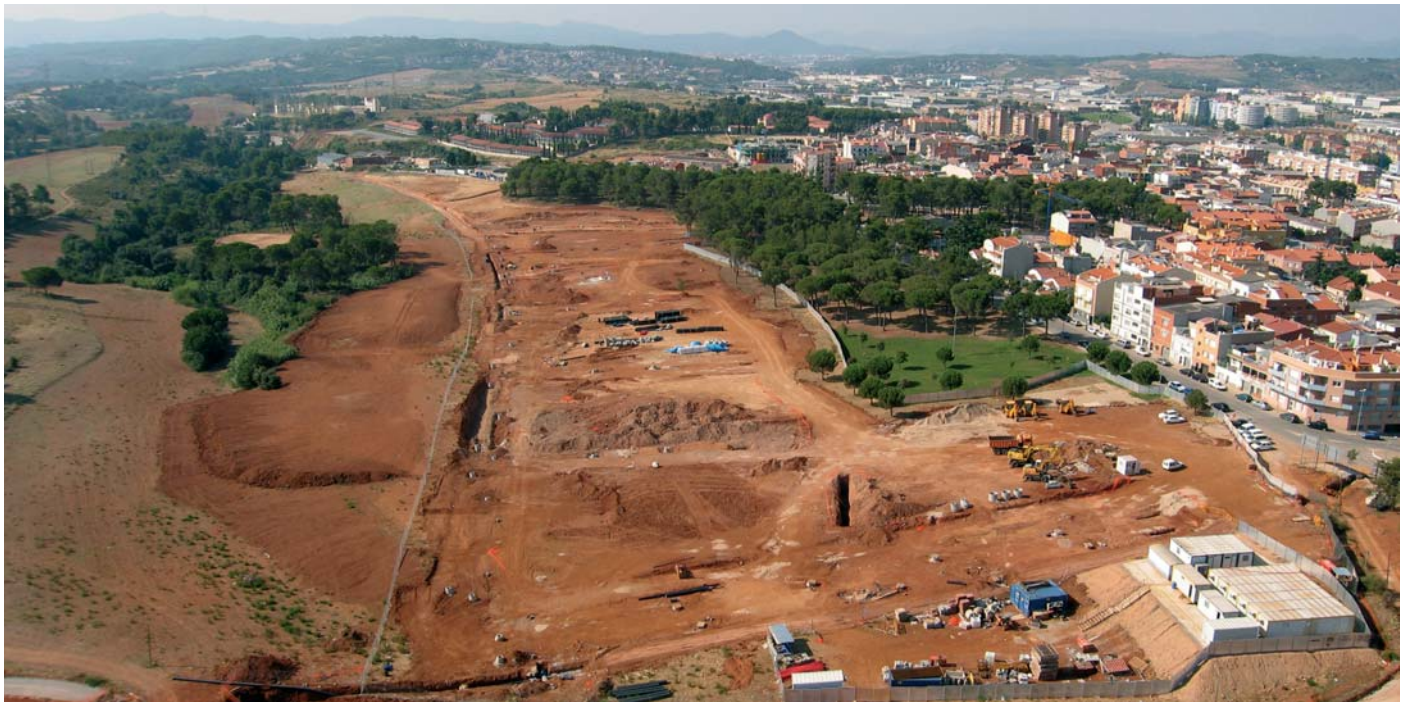
Vista de les obres d'urbanització dels terrenys on aniran els pisos de promoció pública
