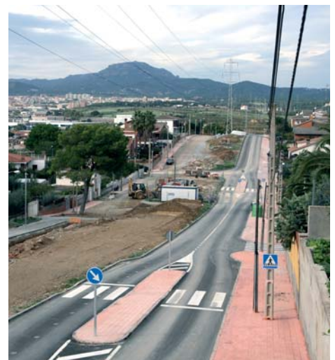
Obres d'urbanització de l'avinguda d'Àfrica
