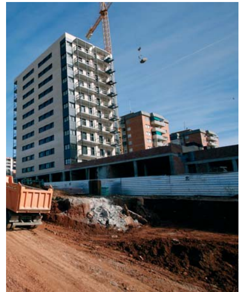
Construcció de l'estació dels FGC a Can Roca
