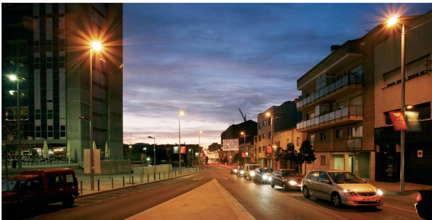
Vista de nit d'un tram de la carretera de Montcada, on ja s'ha fet la substitució de l'enllumenat
