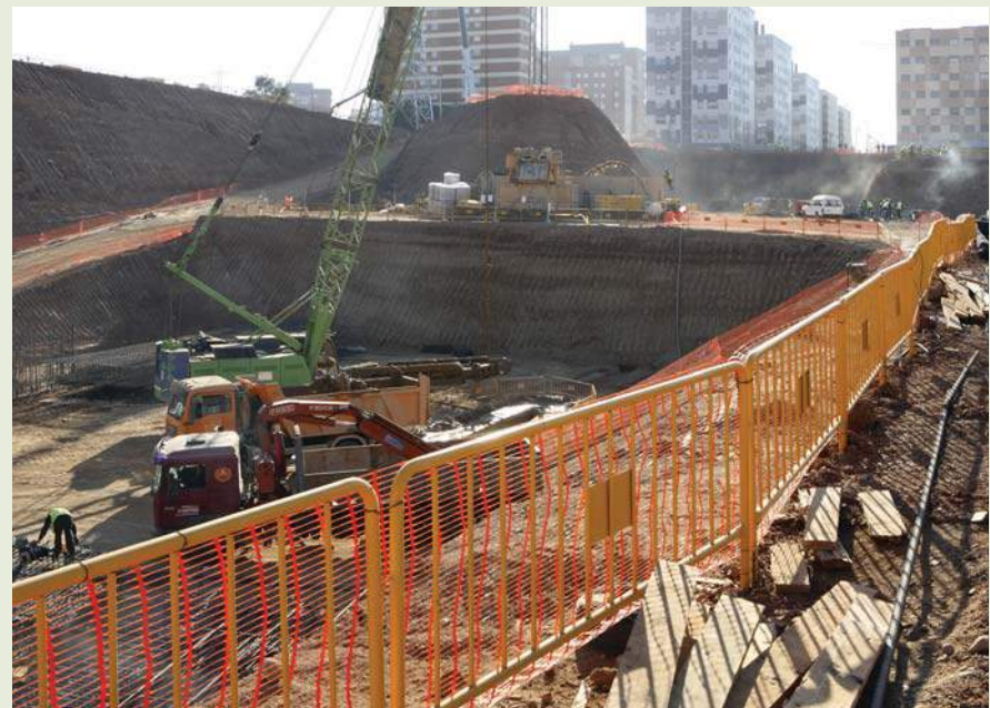
Construcció del pou d'atac de la tuneladora, a Can Roca.
