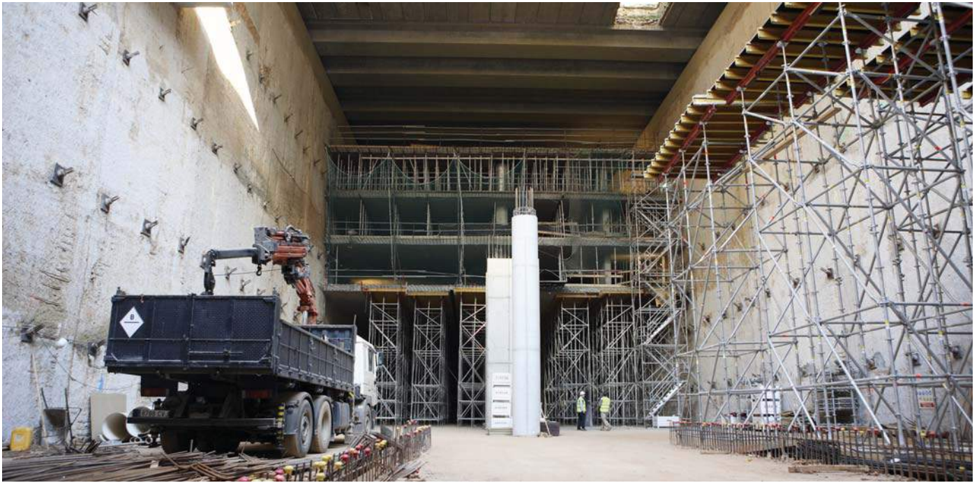
Estructura de l'estació de Can Roca amb les plantes d'aparcaments al fons
