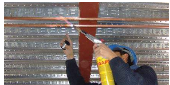
Treballs de rehabilitació a l'antic ajuntament de Sant Pere.
