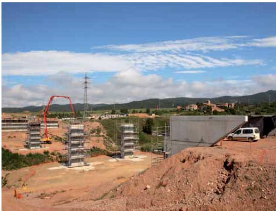
Construcció del viaducte de Can Bogunyà
