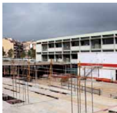
Obres de reforma integral del CEIP França
