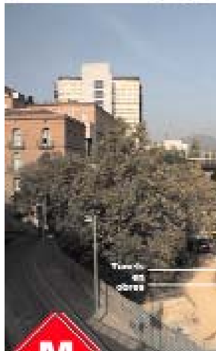
Metro de Terrassa
