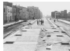
Urbanització de la rambla de Francesc Macià (1984)
