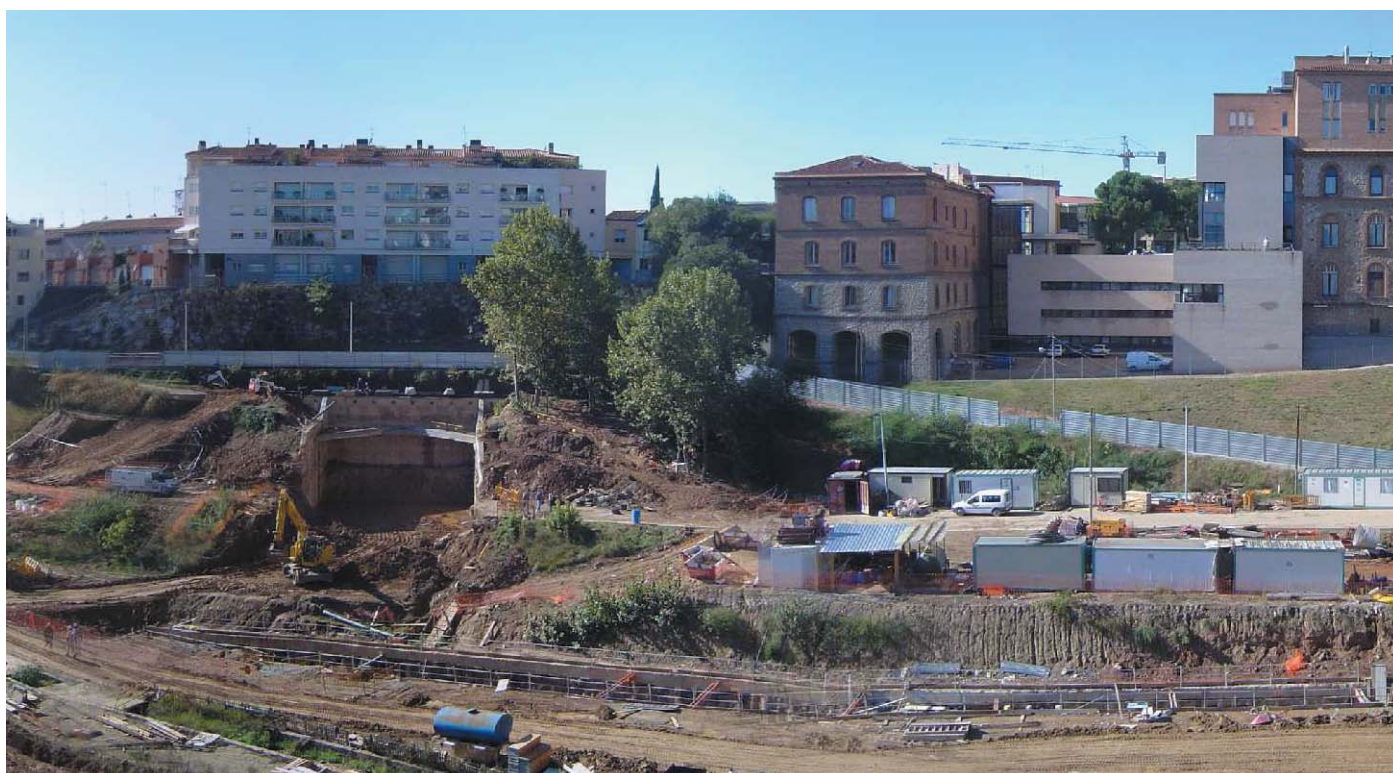
L'embocadura del nou túnel està situada a l'altura de l'Hospital de Sant Llàtzer. Els treballs de perforació començaran al febrer
