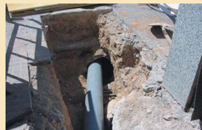
Renovació de col·lectors i clavegueram (1,17 milions)
