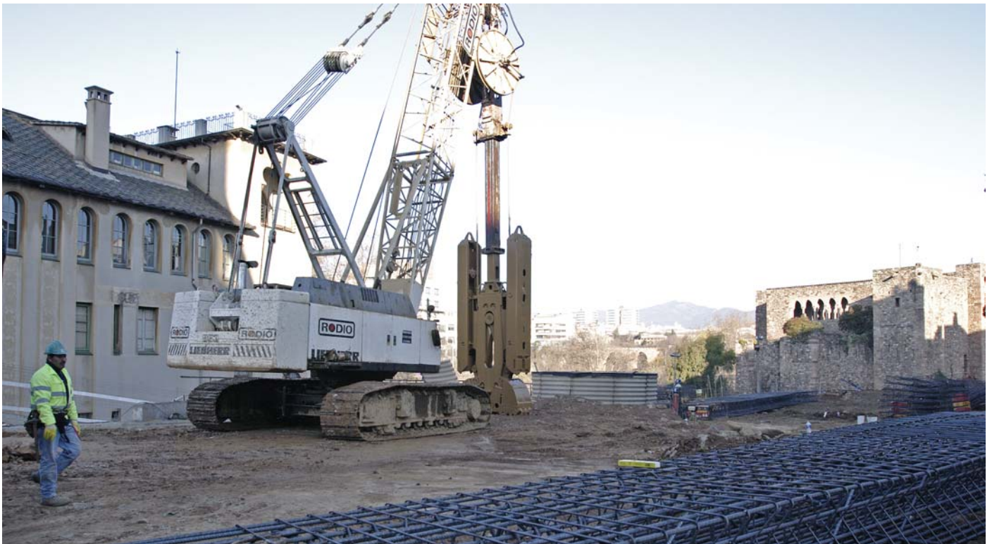
Obres d'urbanització a l'avinguda de Jacquard amb motiu de la futura estació subterrània UPC-Vallparadís
