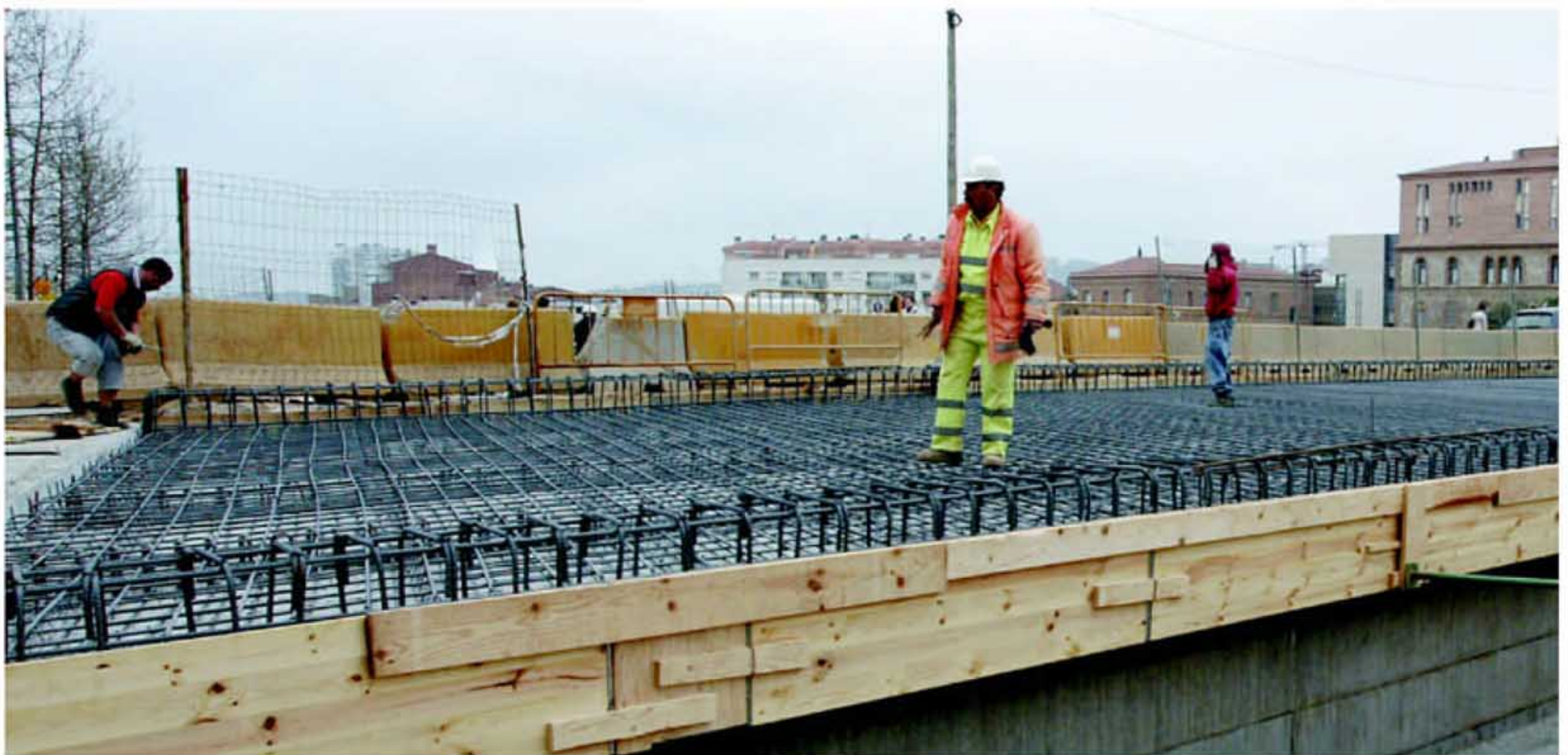
Col·locació d'unes bigues gegants del pont provisional de l'avinguda de Jacquard. En aquest zona es construeix la nova estació UPC-Vallparadís
