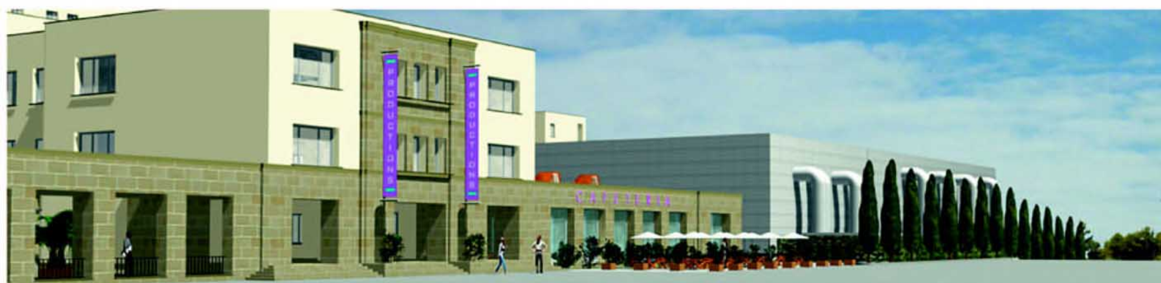
El futur Parc Audiovisual és un exemple de l'aposta per nous sectors generadors de riquesa i coneixement
