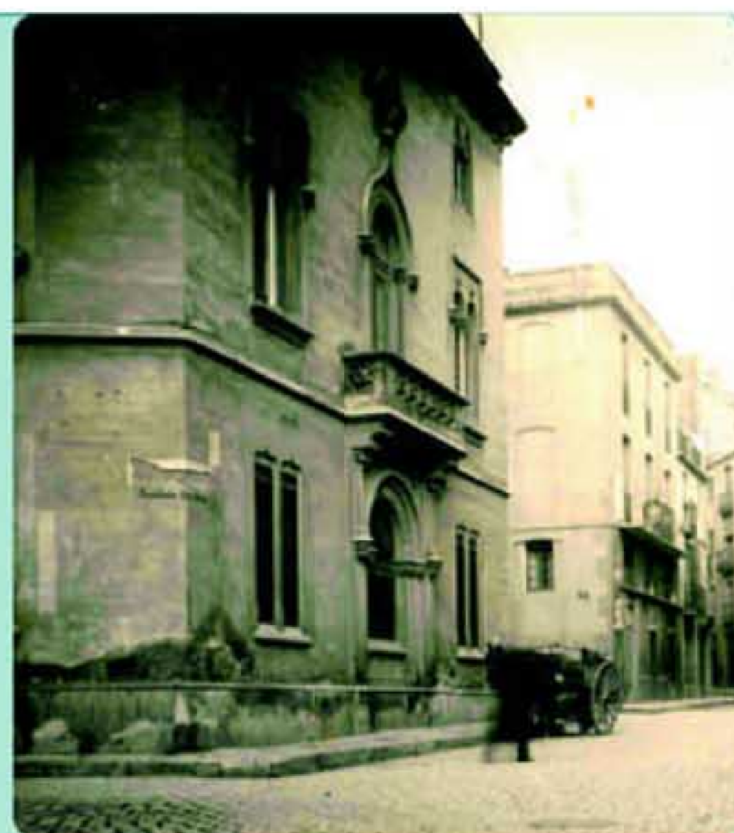
Portal Nou, Mosterol i del Vall amb la Rutlla, on el 1940 encara es podia veure aquell edifici modernista.
