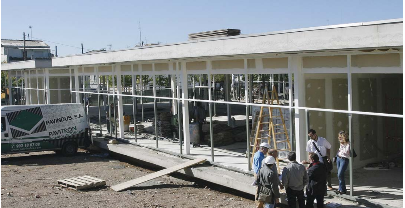
La biblioteca que es construeix al costat el futur parc té un cost d'1.317.000 euros
