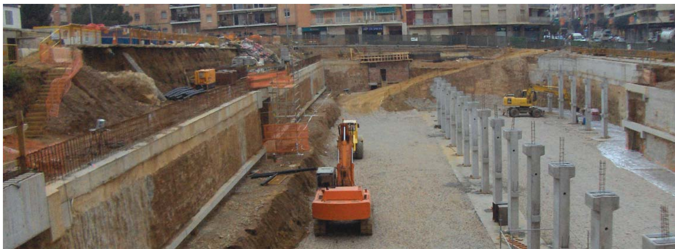
Obres del pàrquing de la plaça de Lluís Companys. L'Ajuntament invertirà 10 milions en la construcció d'aparcaments subterranis el 2006
