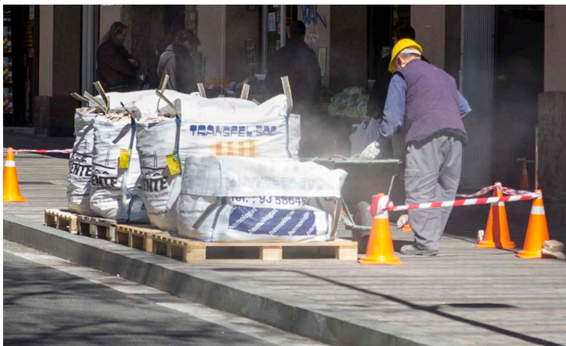
Figura 74: Activitat de construcció/demolició a la via pública. Font: BCNecologia.
