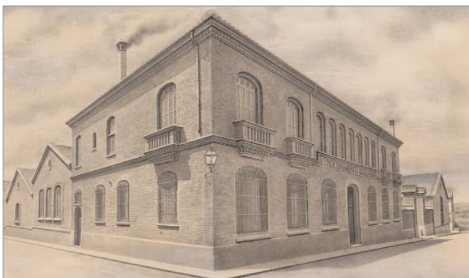
Façana de l'edifici del Condicionament Terrassenc.
