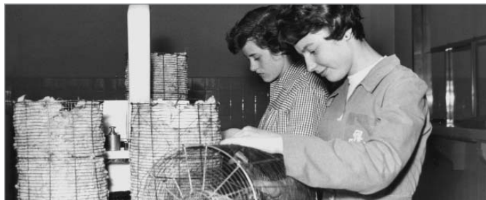
Operàries treballant a les instal·lacions del Condicionament.
