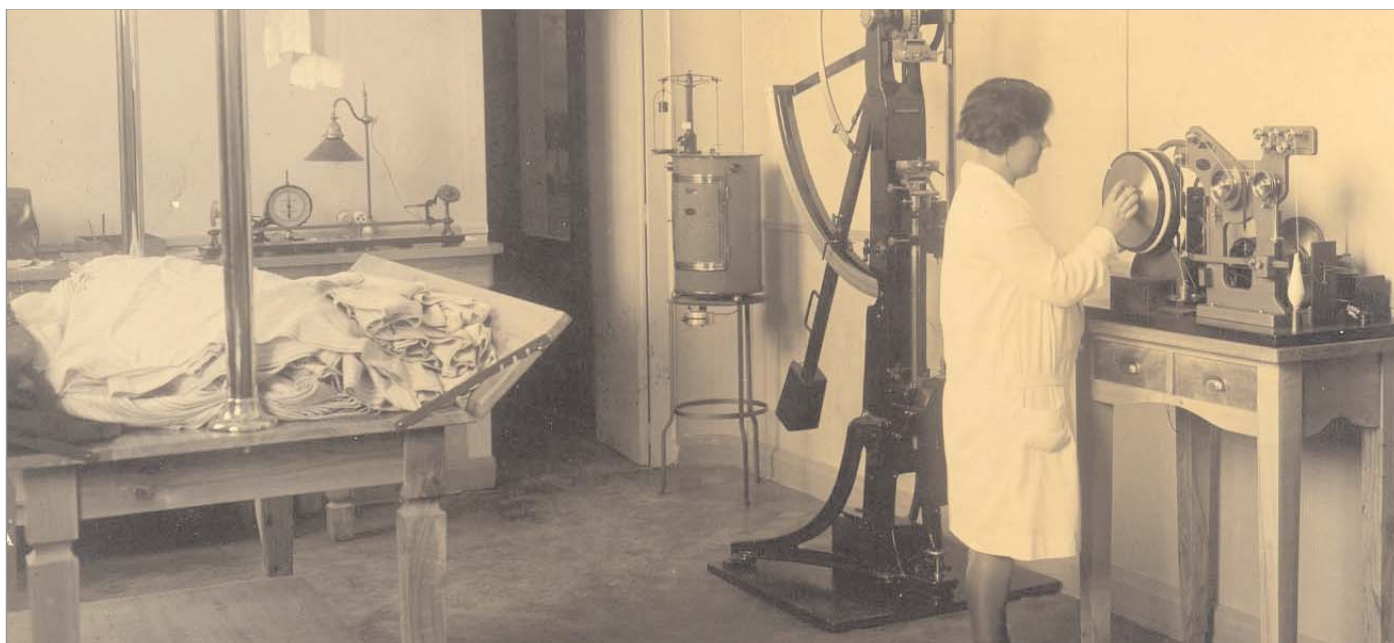
Treballadores a les instal·lacions del Condicionament.
