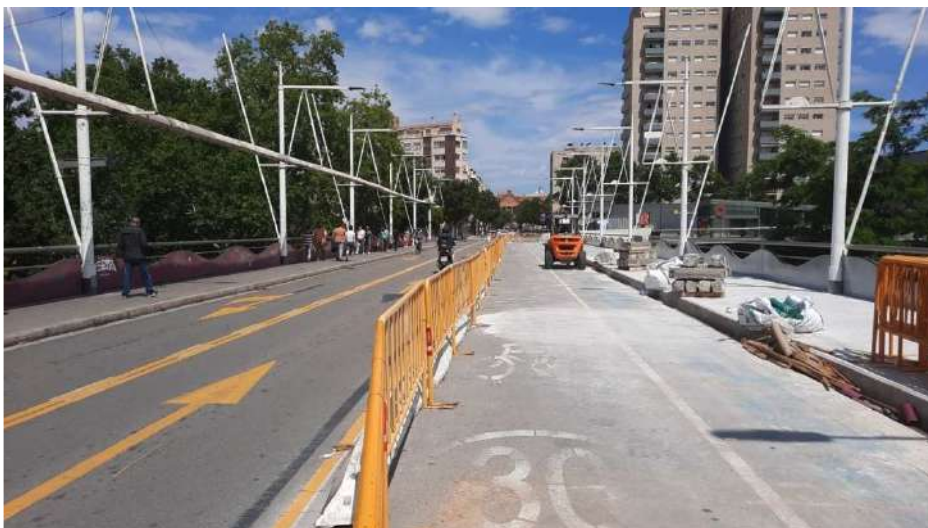
02 - Obres Pont del Passeig
