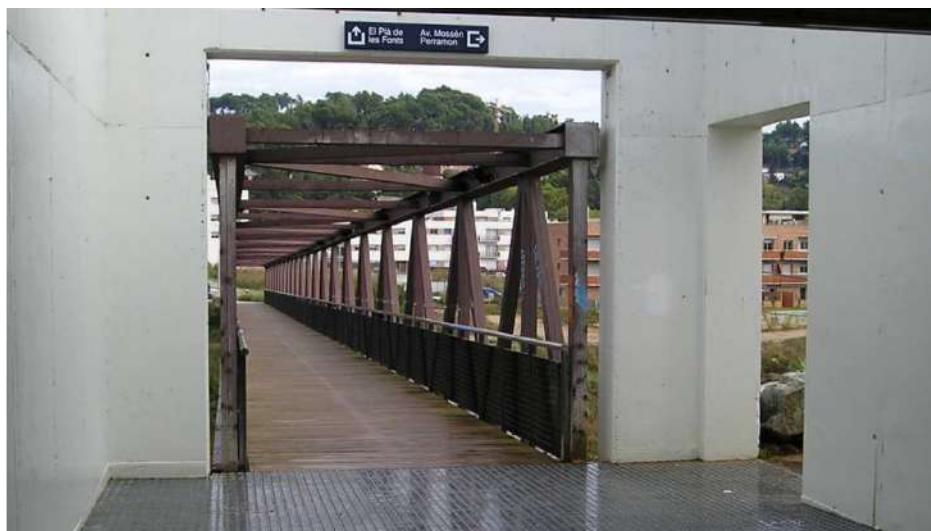
01 - Millora de l'accessibilitat a l'estació de Les Fonts
