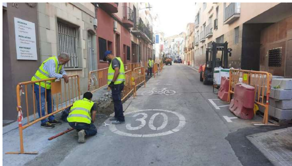
15 - Obres C. Pare Font
